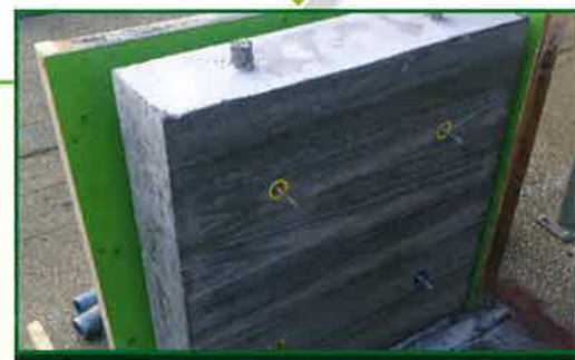
3 固まったら型枠を取り外す
